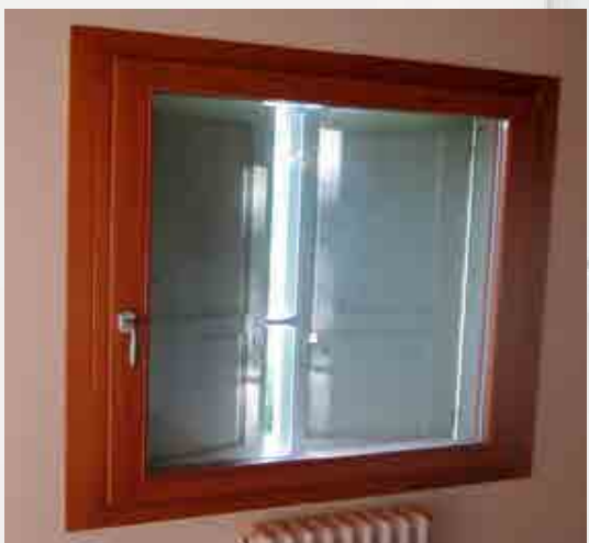
Montaggio filo muro interno con cornici complanari
